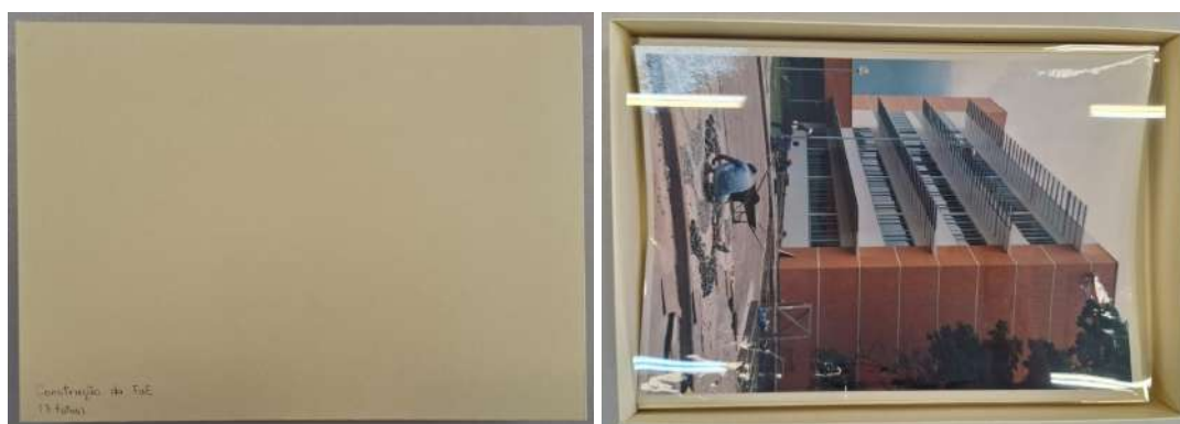
Figuras 22 e 23- Fotografias da Coleção “Construção da FaE”
