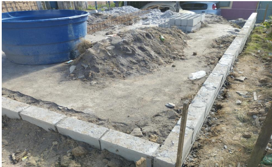
Figura 46: 2ª etapa: alvenaria.
