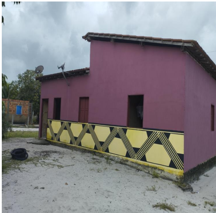
Figura 59: Casa de alvenaria.
