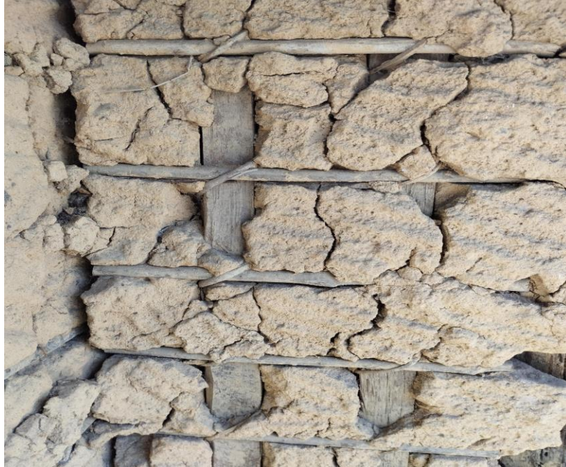
Figura 33: Parede amarrada com cipó no modo tradicional.
