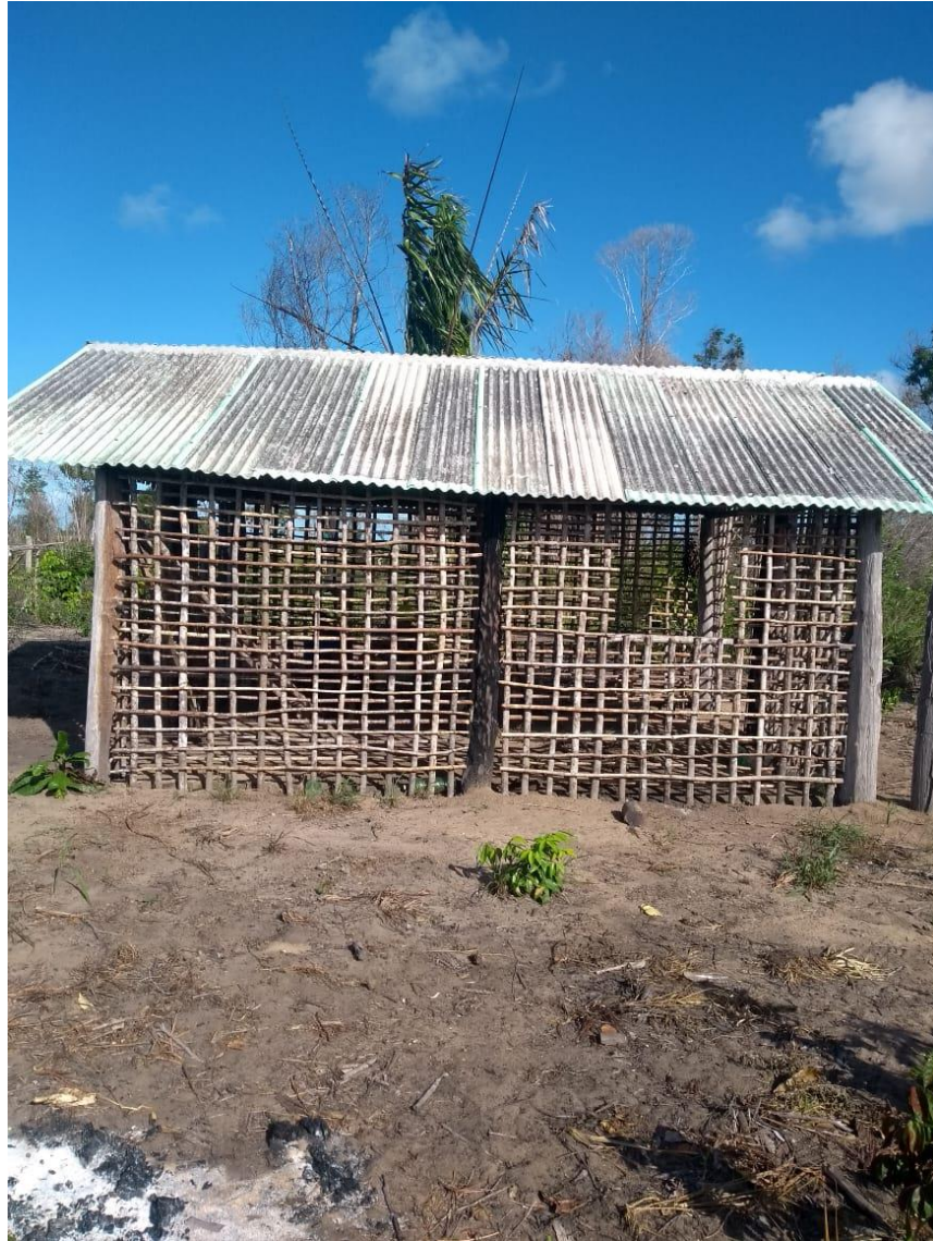
Figura 20: Casa de taipa coberta com telha amianto.
