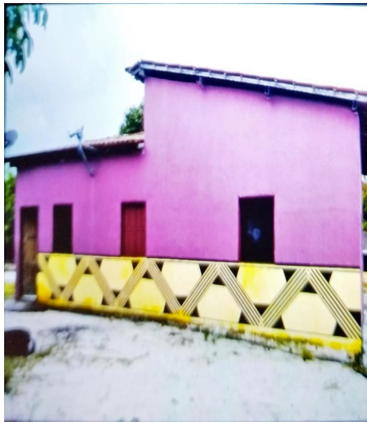
Figura 16: Casa de alvenaria.
