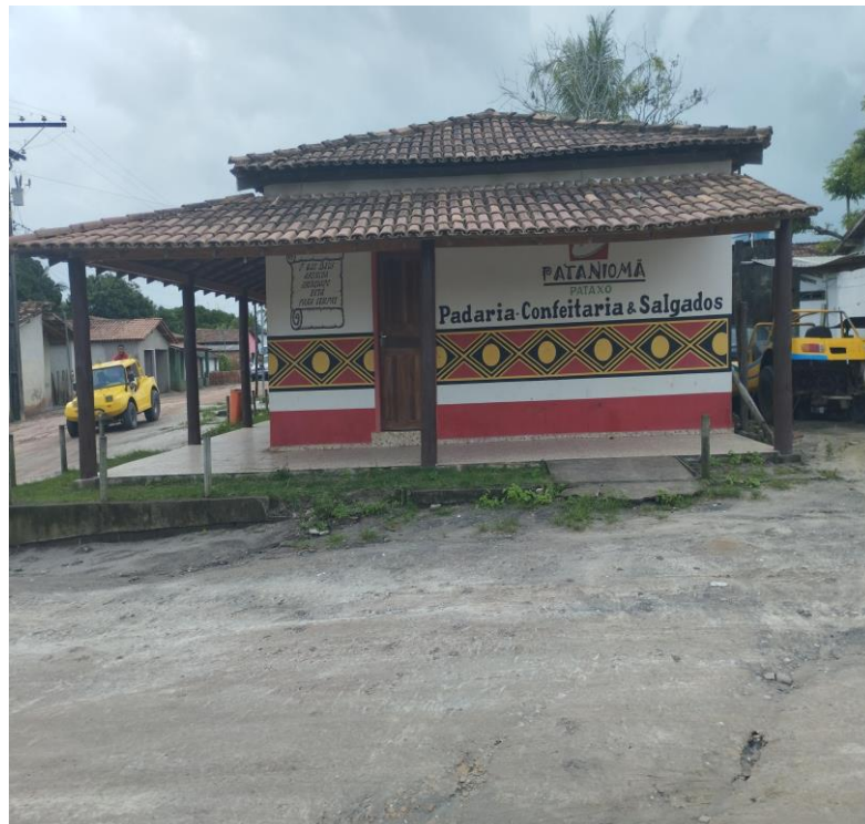
Figura 52: Casa de alvenaria concluída.
