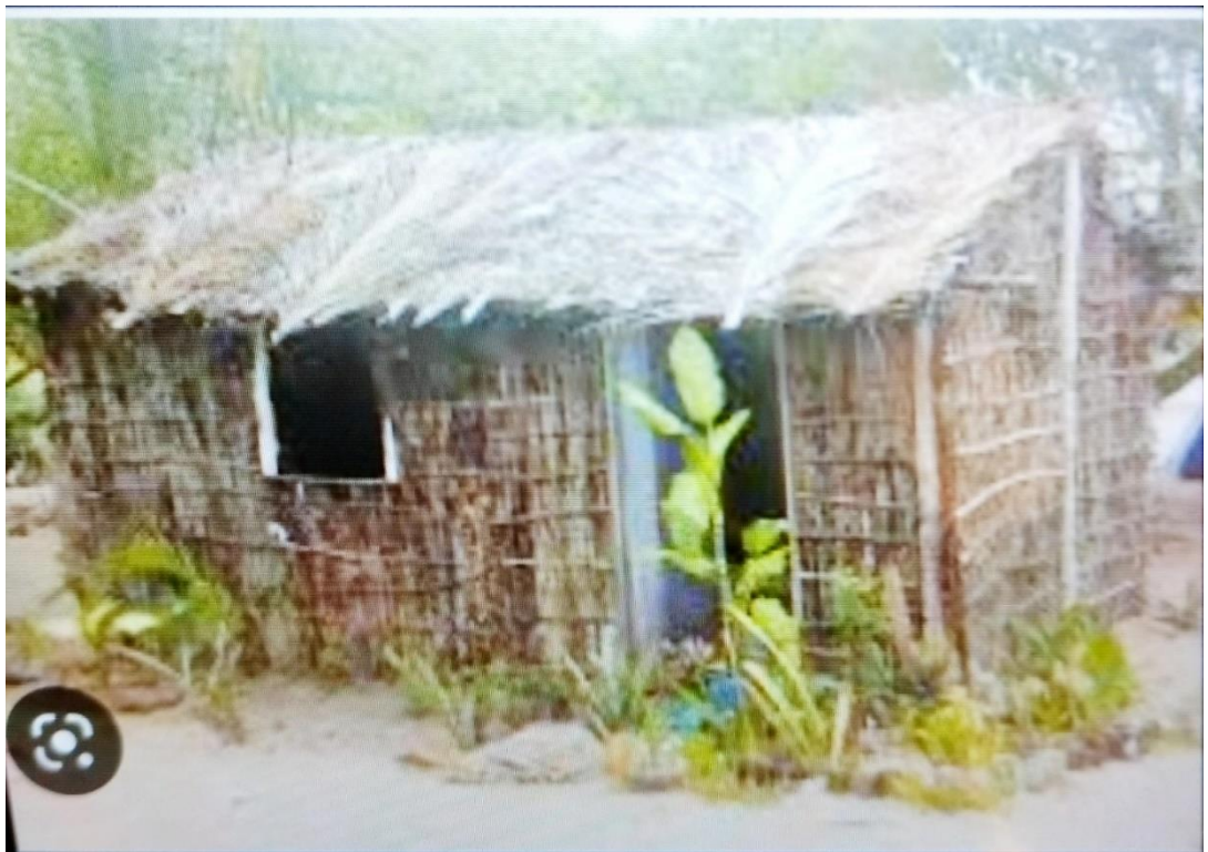
Figura 3: Casa de palha.
