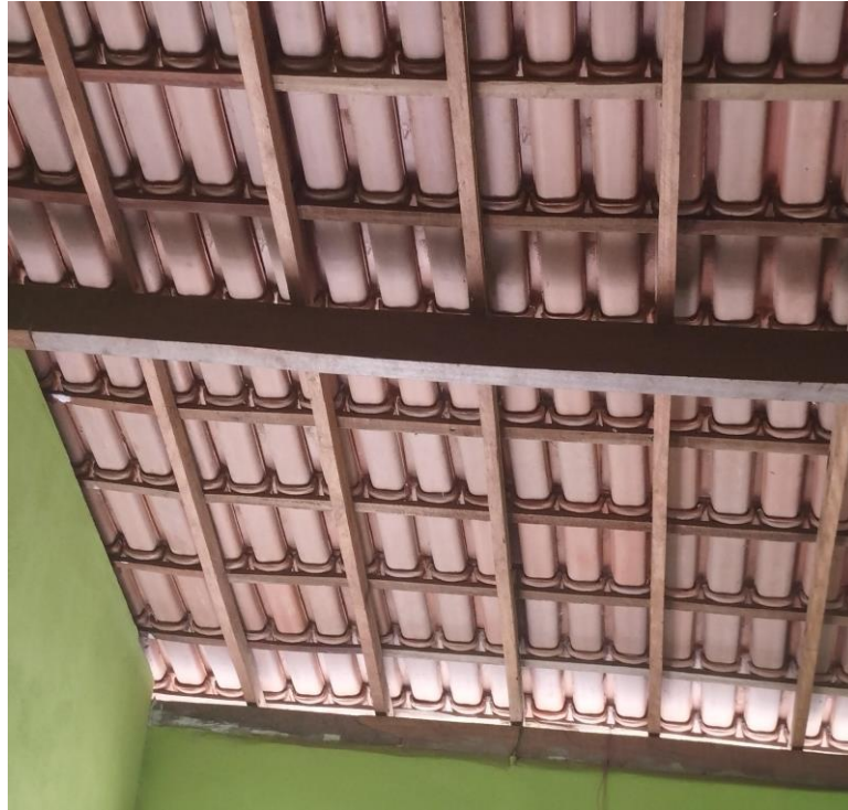
Figura 51: Telhado completo (caibros, ripas, peças e telha).
