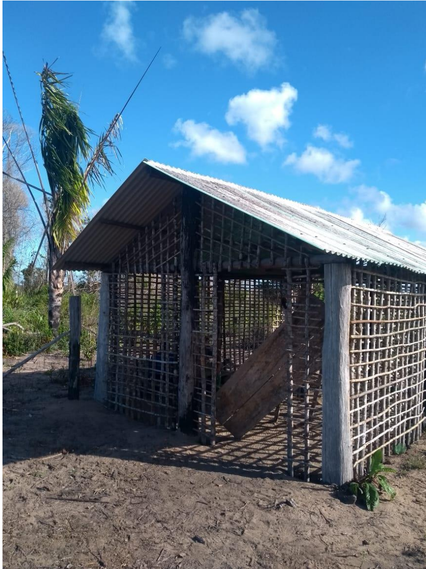
Figura 21: Casa de taipa envarada e enchimentada.
