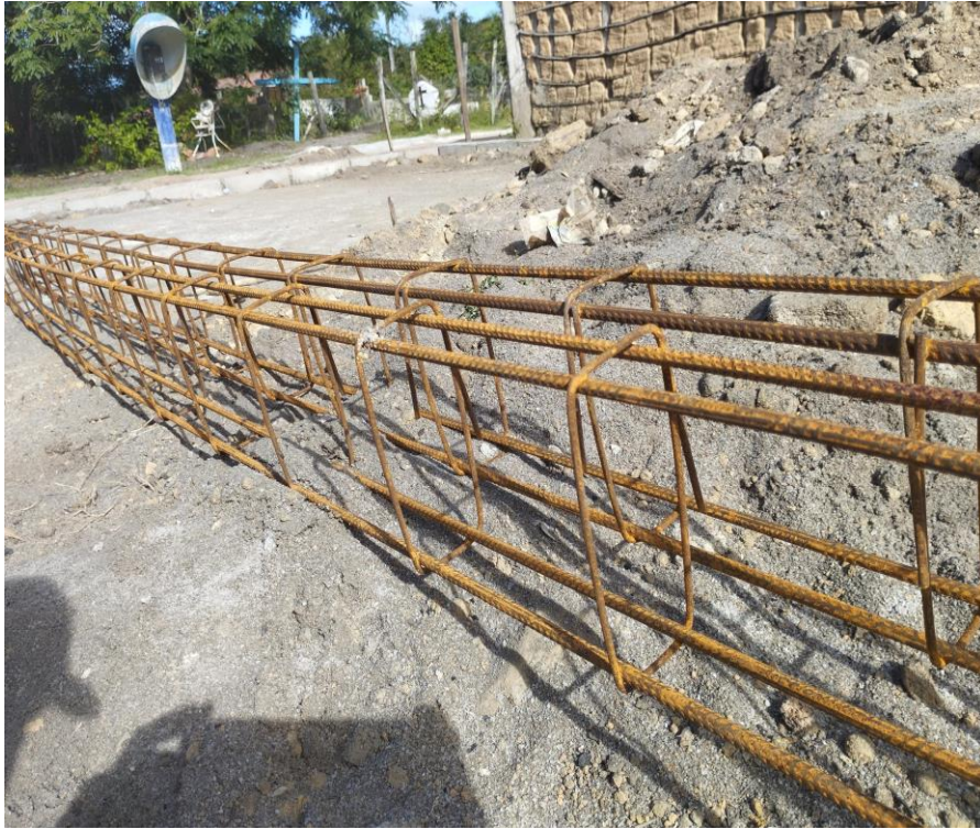
Figura 47: 3º etapa: vigas.
