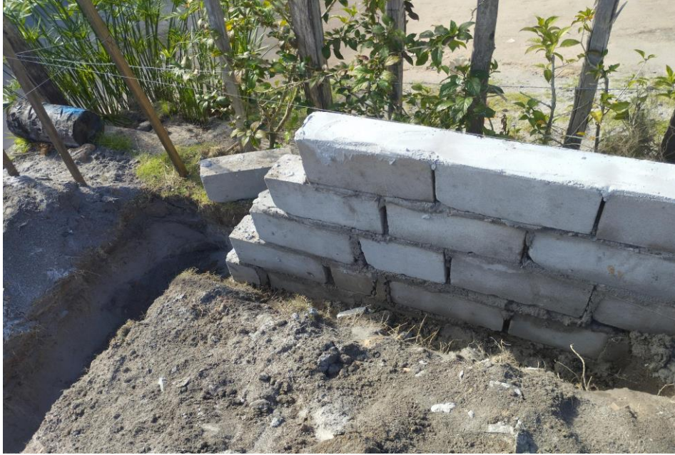
Figura 45: 1ª etapa: valetas.
