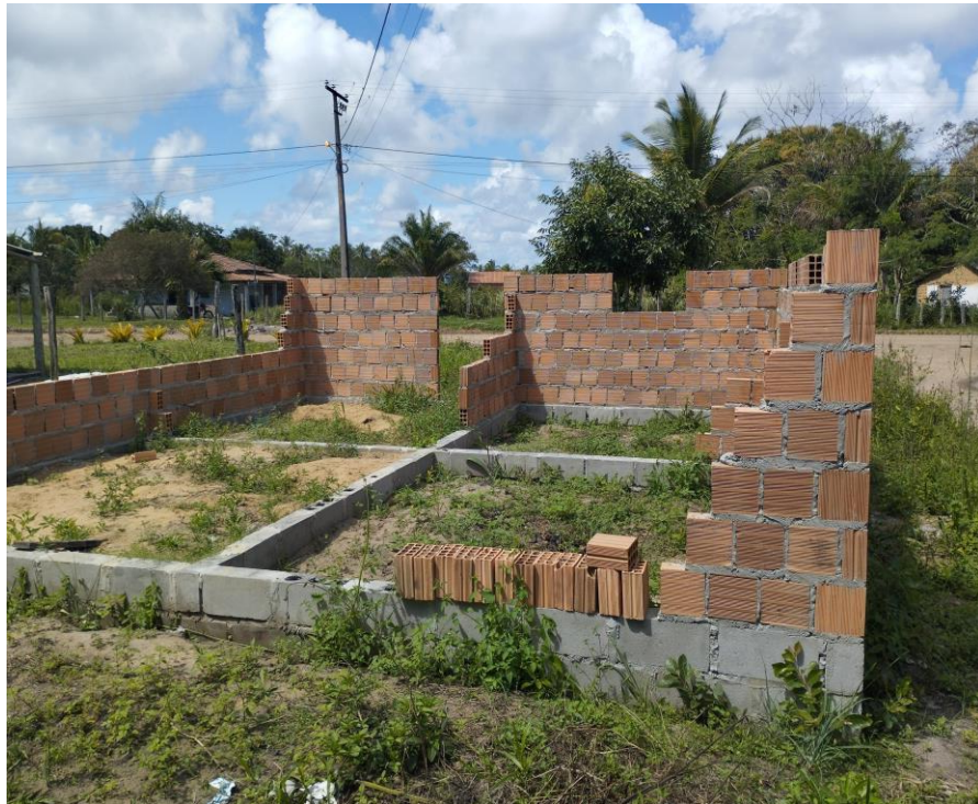
Figura 48: 4º etapa: paredes.
