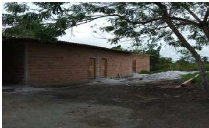
Figura 6 - As 3 salas em fase de construção (recursos de doações e rifas organizadas pela equipe da escola)
