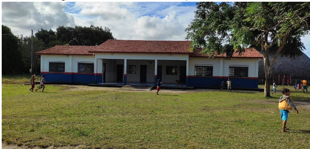
Figura 12. Prédio construído em 2011 pelo Estado da Bahia.
