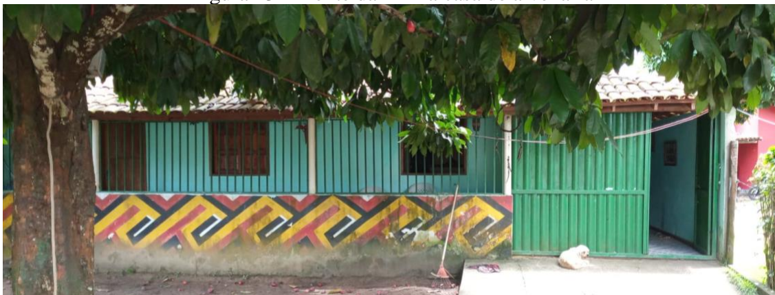
Figura 13 - Frente da minha casa de alvenaria
