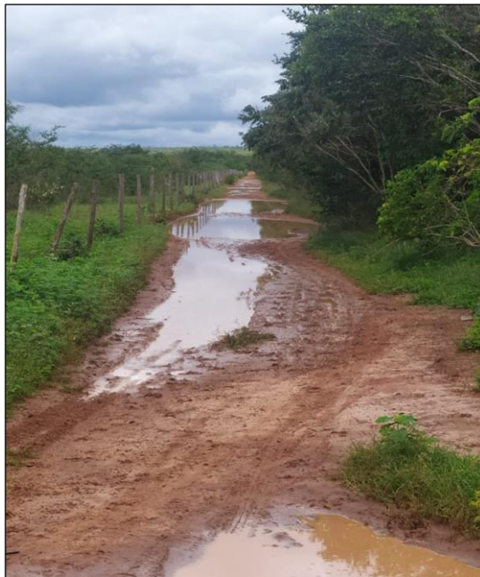
Figura 11: Estrada de acesso a aldeia Caraíbas
