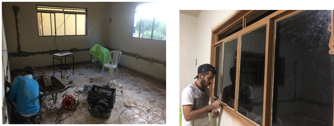
Figuras 20 a 23: Reforma do novo prédio da Rádio Xakriabá. Fonte: Joel Xakriabá, 2021.
