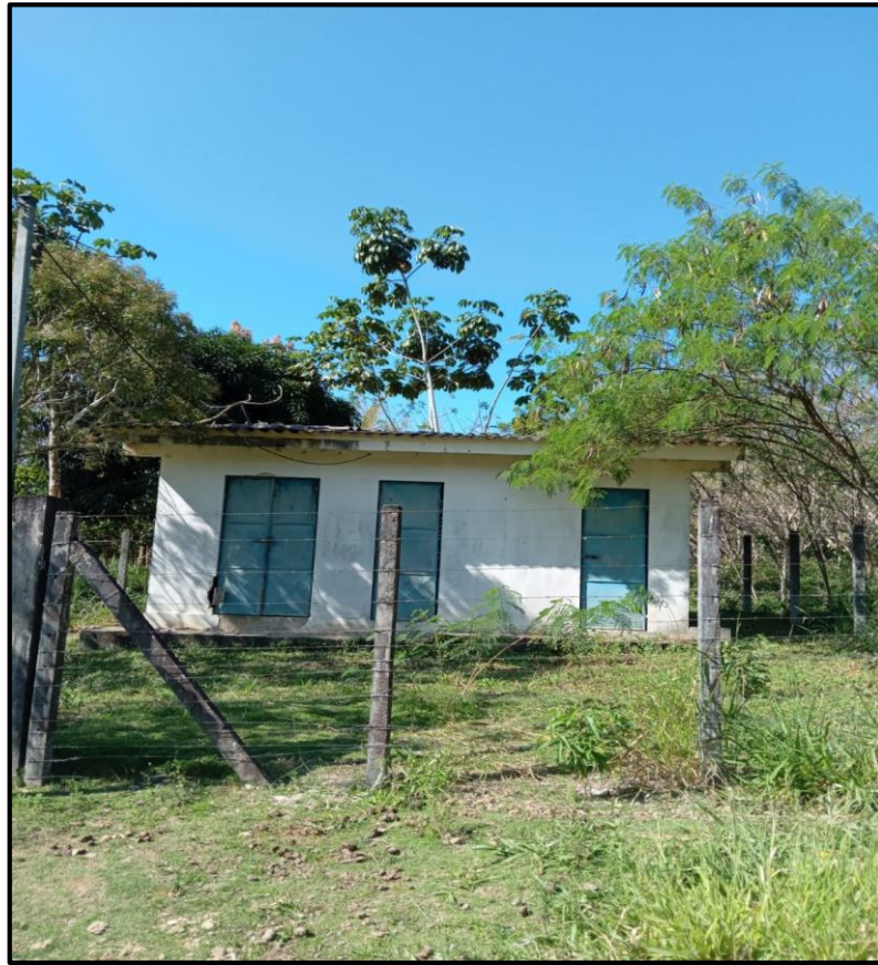
Figura 13 - Casa do Poço Artesiano que abastece a comunidade.
