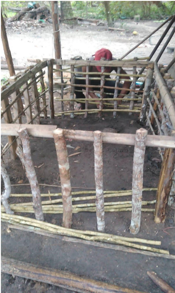
Foto 16 – Construção do fogão. Fotografia de Arildes Nascimento da Conceição (20/08/2020).
