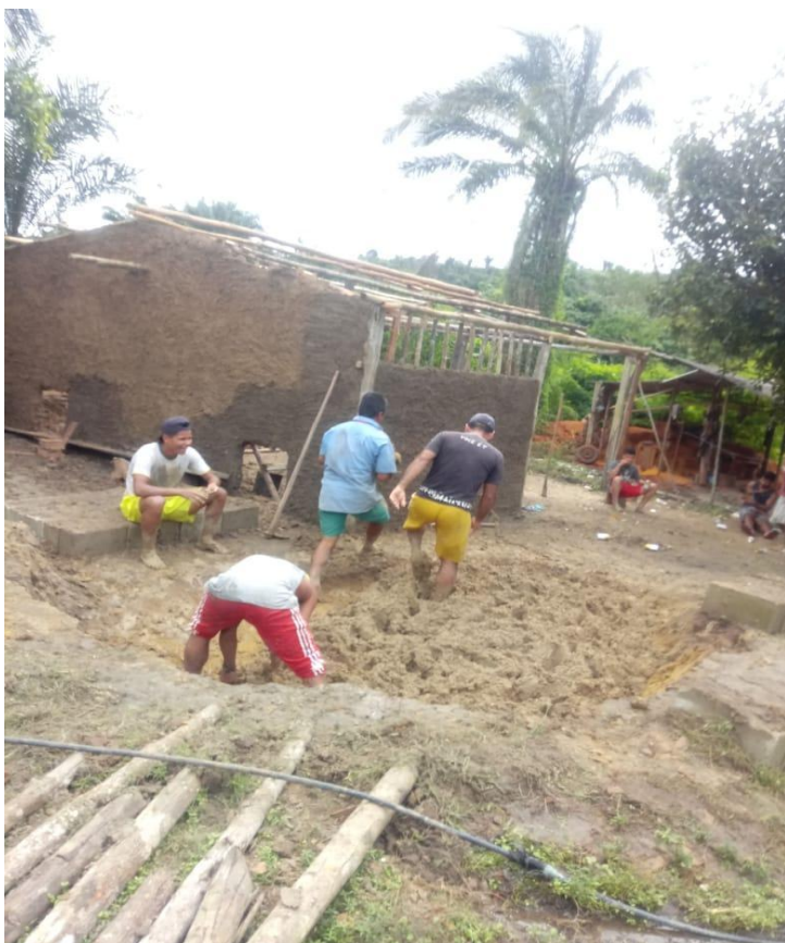
Foto 21 – Construção da Casa de Farinha. Fotografia de Valtemir da Silva Nascimento (15/07/2020).
