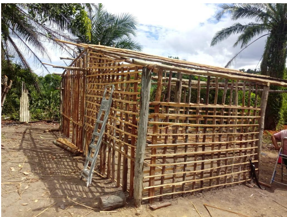
Foto 22 – Construção da Casa de Farinha. Fotografia de Valtemir da Silva Nascimento (15/07/2020).
