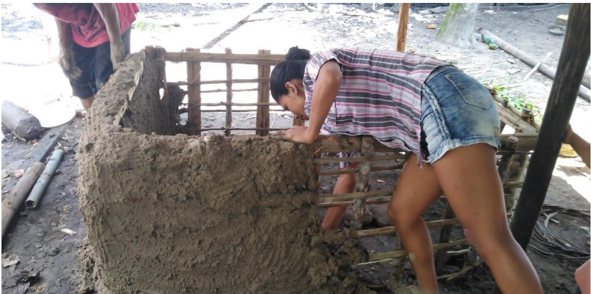
Foto 16 – Construção do fogão. Fotografia de Arildes Nascimento da Conceição (20/08/2020).
