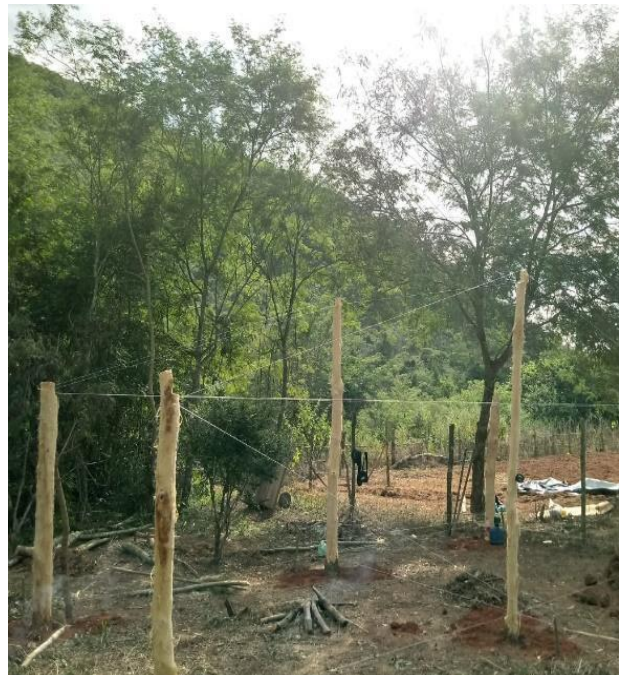
Imagem 7: construção da casa de barro. Fonte: Yan Cruz, 2020
