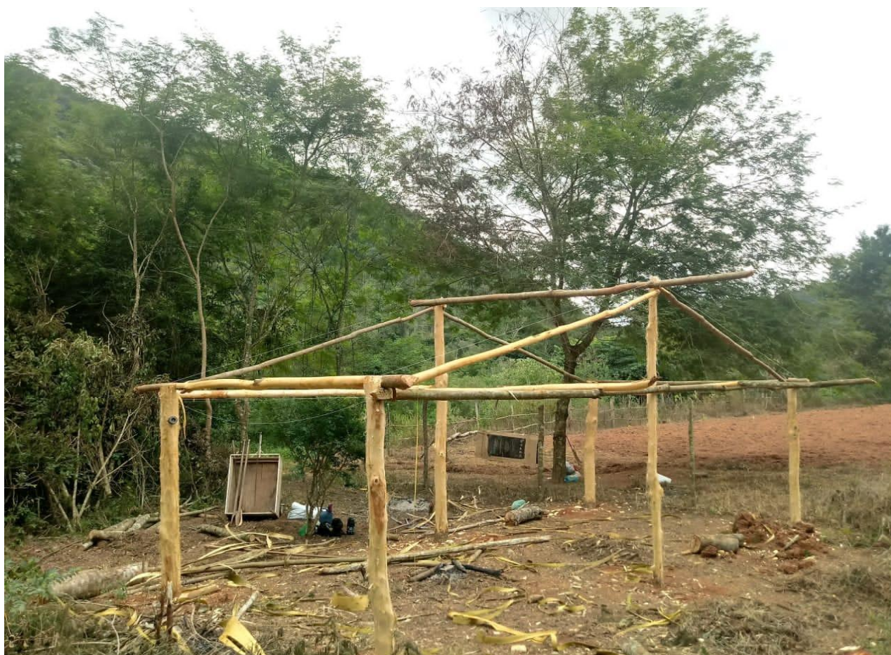
Imagem 8: construção da casa de barro. Fonte: Yan Cruz, 2020
