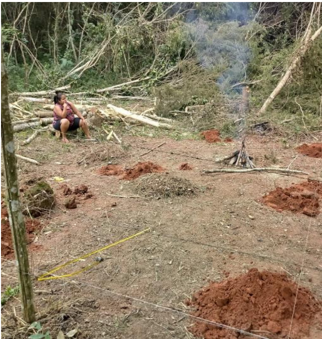
Imagem 6: construção da casa de barro. Fonte: Yan Cruz, 2020
